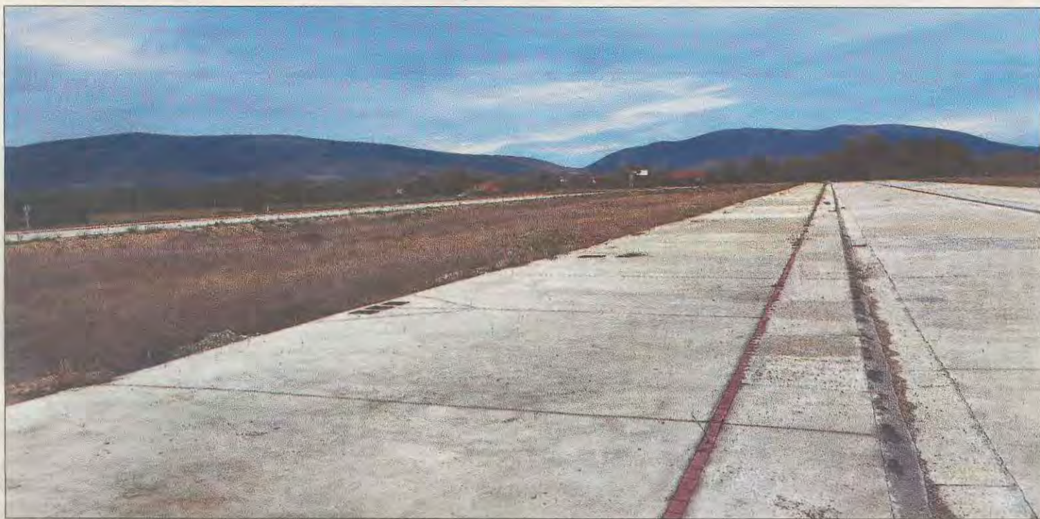
Una de las islas de terreno donde irán las naves adosadas del polígono de Montija, ya dotado prácticamente con todos los servicios. / A.C.
